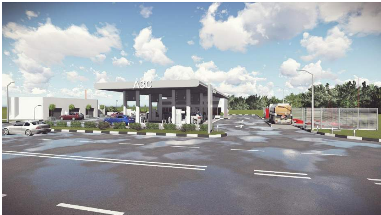
Подсветка островка и зоны въезда\выезда на АЗС
